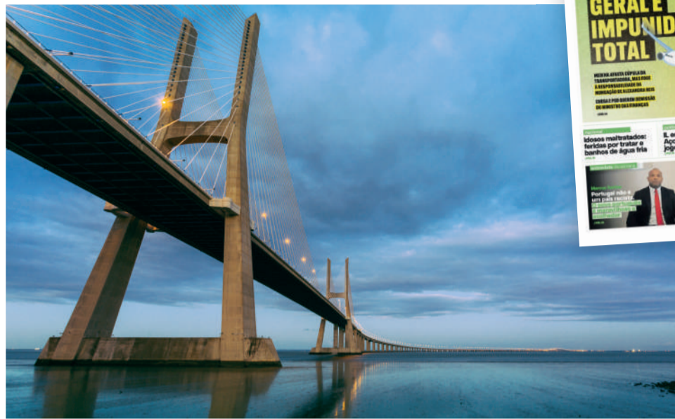
PONTE VASCO DA GAMA | © DR
